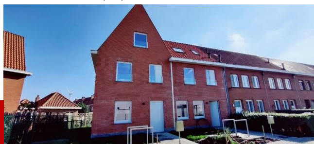
Vervangingsniewbouw van 3 naar 4 huurwoningen
